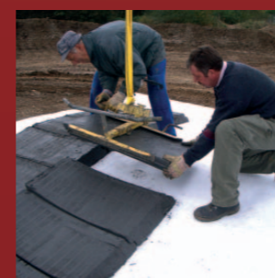
Verlegung von „Jumbo“-Elementen
