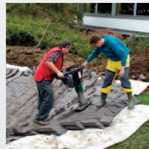
Verkneten der „Uni“-Elemente mit Stampfer
