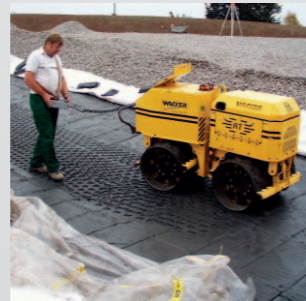
Verkneten der „Jumbo“-Elemente mit „Schaffußwalze“
