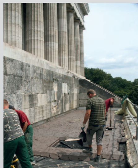
Gewölbeabdichtung Walhalla: mineralische Abdichtung unter Extrembedingungen
