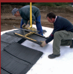
Verlegung von „Jumbo“- Elementen
