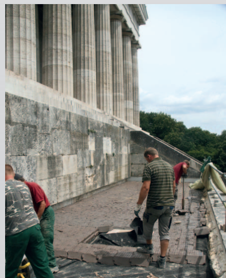
Gewölbeabdichtung Walhalla: mineralische Abdichtung unter Extrembedingungen
