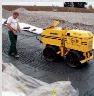
Verketten der „Jumbo“-Elemente mit „Schaffußwalze“
